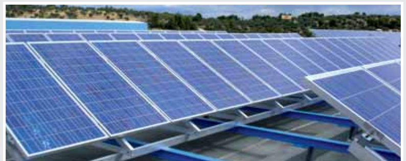
Erste PV Anlage (20 kWp) der Fa. Heliomechanics S.A., auf dem Industriedach der Fa. Papagiannaki Bros OE mit Solarmodulen von CENTROSOLAR
