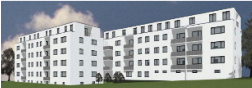
Ein Blockheizkraftwerk versorgt diese beiden renovierten Wohnblöcke in Meersburg am Bodensee zukünftig mit Wärme und Strom.
