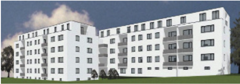
Een blokverwarmingcentrale voorziet deze twee gerenoveerde appartementengebouwen in Meersburg aan de Bodensee in de toekomst van warmte en stroom.
